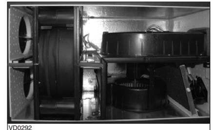
❺ Désengager le harnais du canal de la roue thermique.
